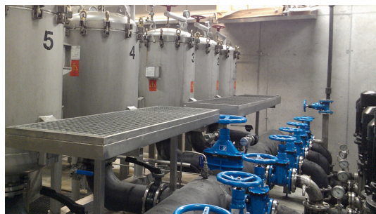
Filterstation zur Partikelfiltration von Quellwasser Filter station für particle removal of well water
